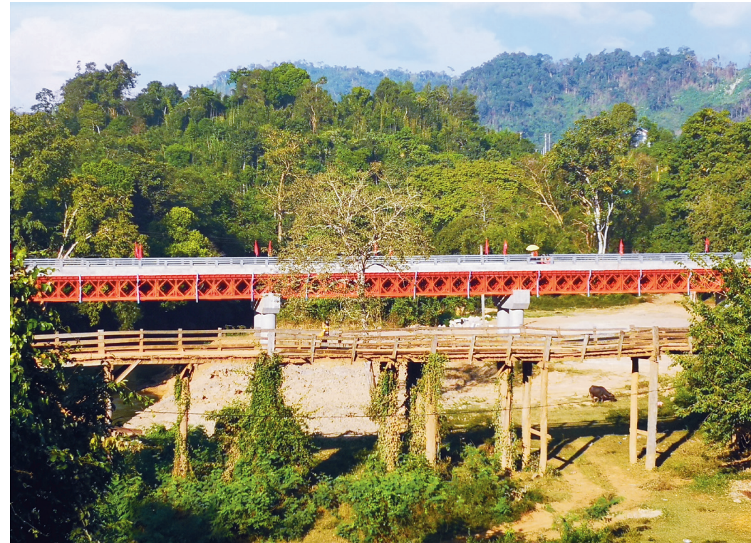
老挝项目村旧桥与新桥
