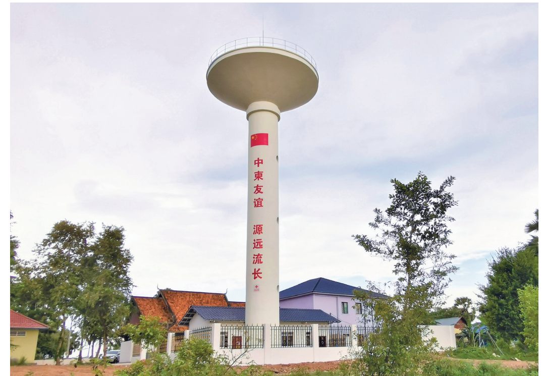
柬埔寨项目援建的供水工程主塔
