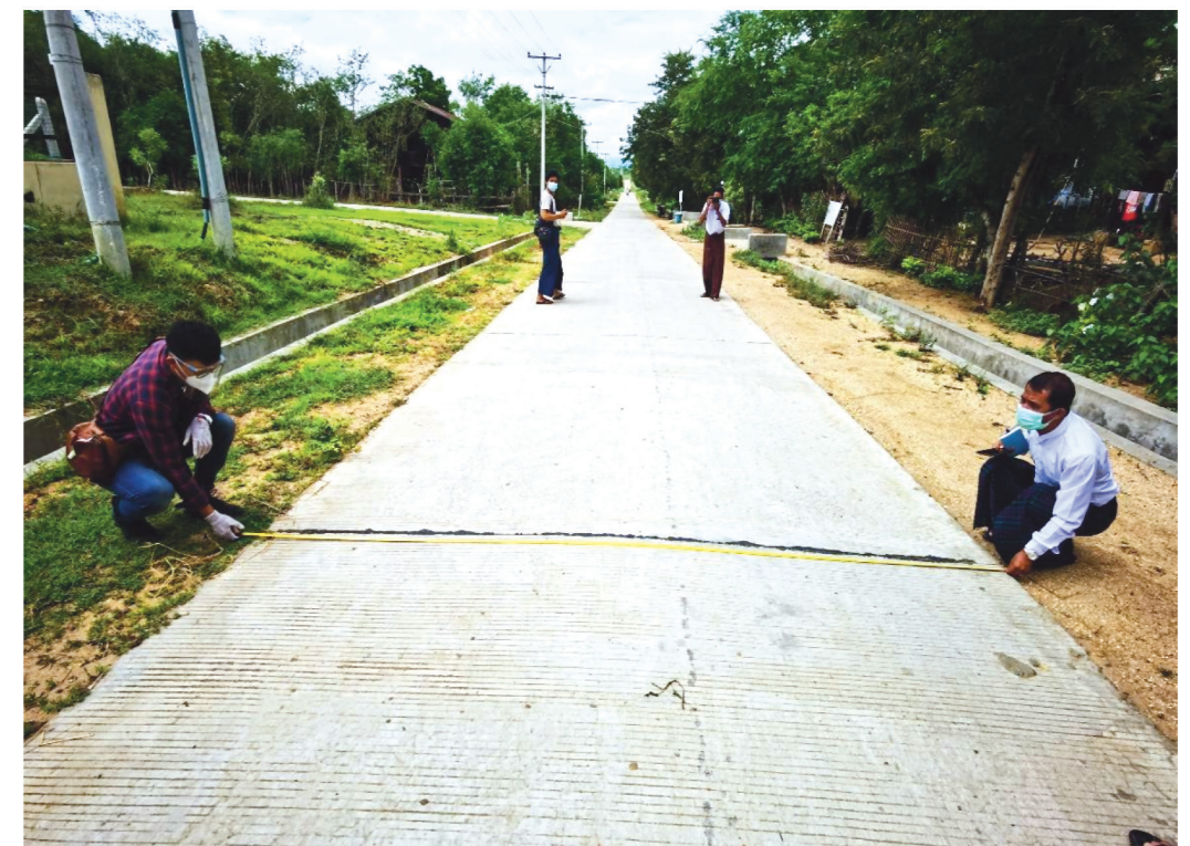
缅甸项目修缮的乡村道路
