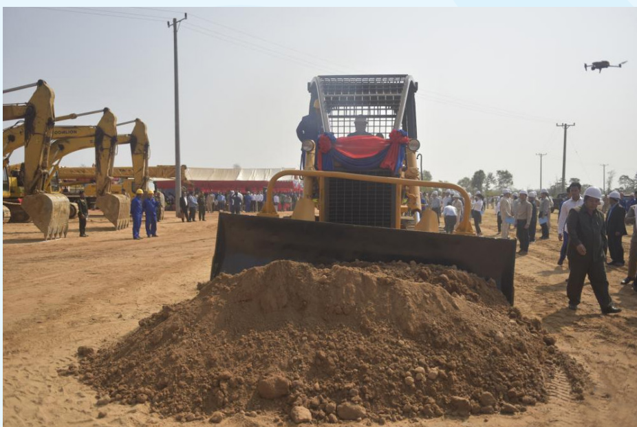
中国援柬埔寨当甘贝水库发展项目正式开工
