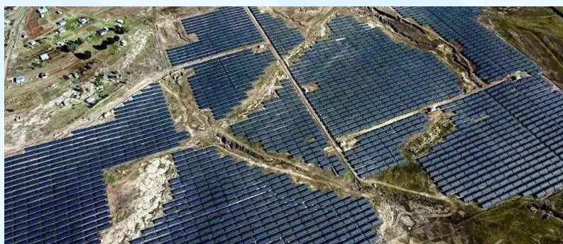
莱索托马费腾光伏电站一期工程 30 兆瓦项目竣工
